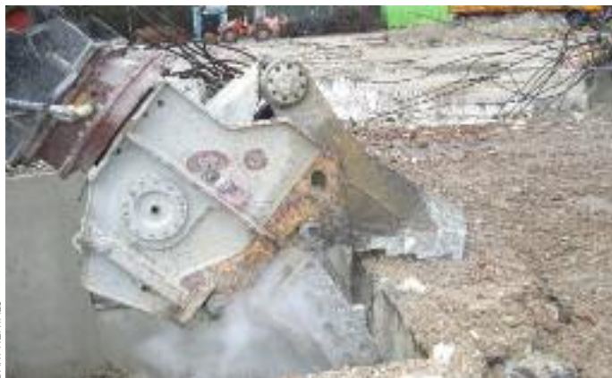
Baggerfahrer Hans Denk: »Im Gebäude ist viel Eisen drinn. Das zwickt der MQP wirklich gut. Der ist »sauschnell« – so etwas habe ich noch nie gehabt.«
